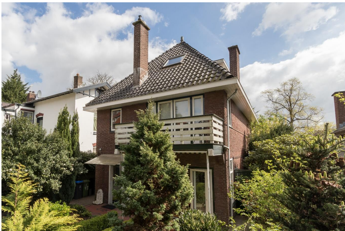
Achterzijde van de woning
